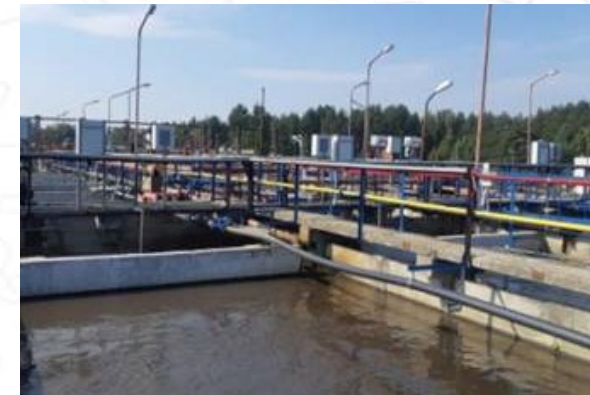
Реконструкция и строительство очистных сооружений
